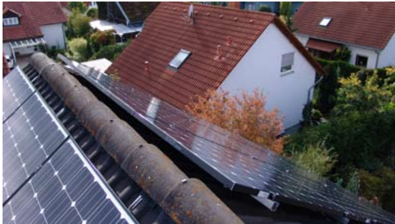
Beispiel für ein OST-West-Dach (Foto Schäffer)
